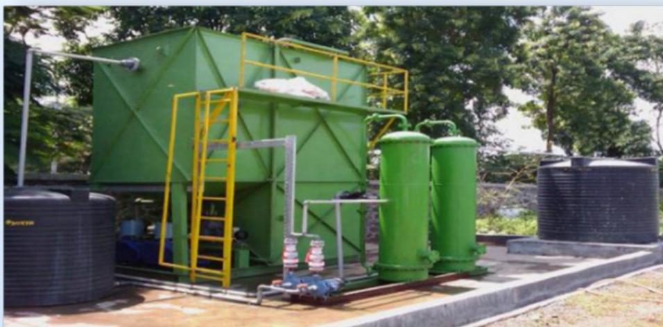
**Estação de Tratamento de Água Pluvial**
