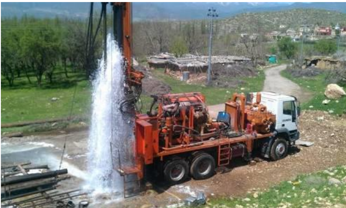
Implantação de Poços Artesianos
